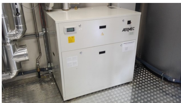
Una pompa di calore nei laboratori Eurac
